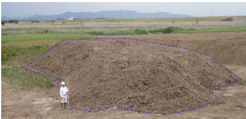
写真-2 原料土 2.6 \text{ 万 m}^3 の改良で分別・除去された葦地下茎
